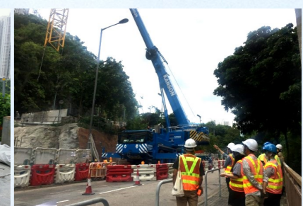
於曉明街視察大型吊運工作
