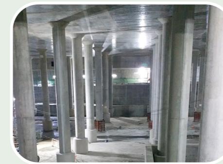
地下蓄洪池的儲水量高達 6 萬立方米
